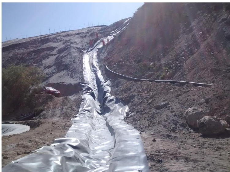
Figura 5: Zanja revestida en HDPE en Tranque III
