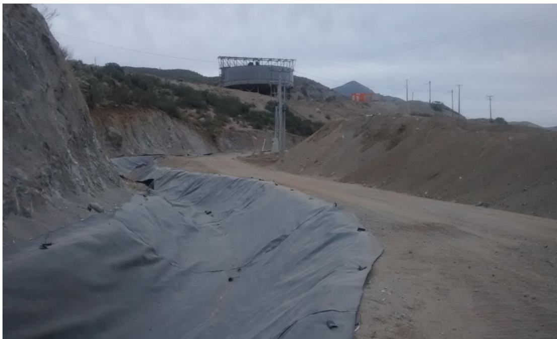
Figura 17: Tramo de canal revestido
