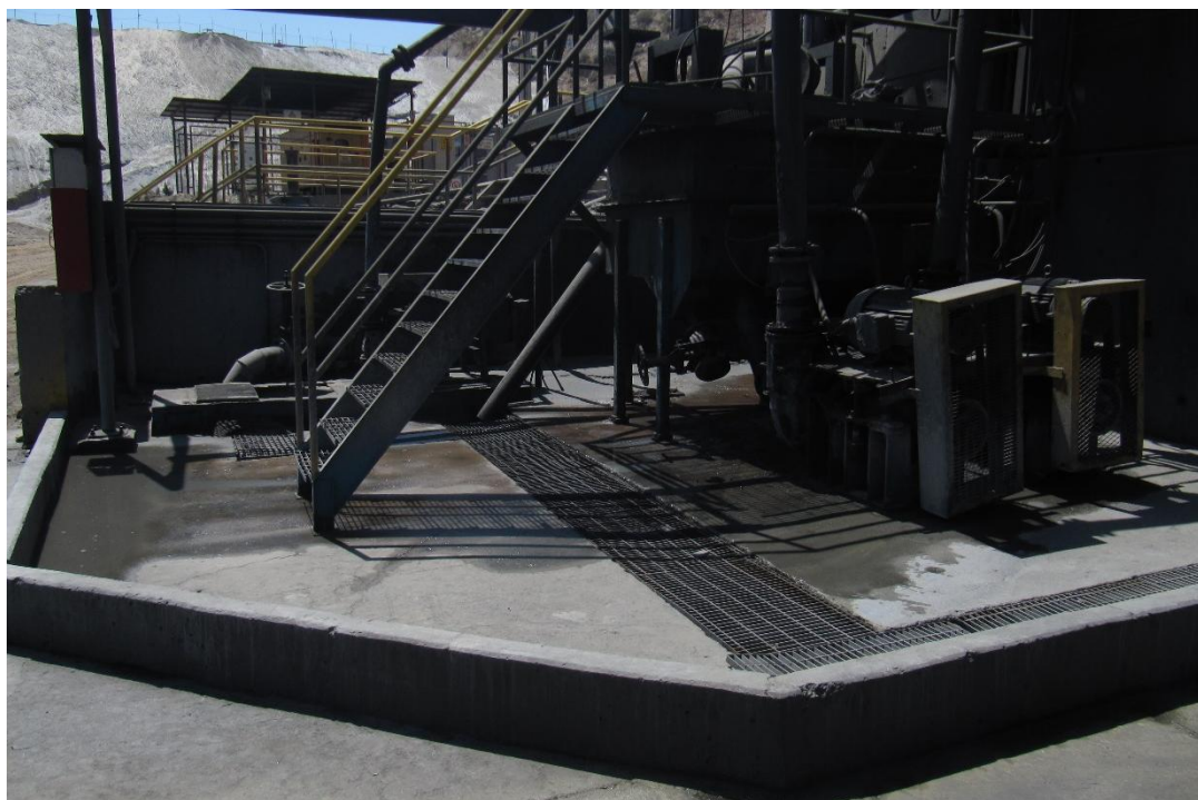
Figura 21. Pretil de contención de derrames, y canaletas.
