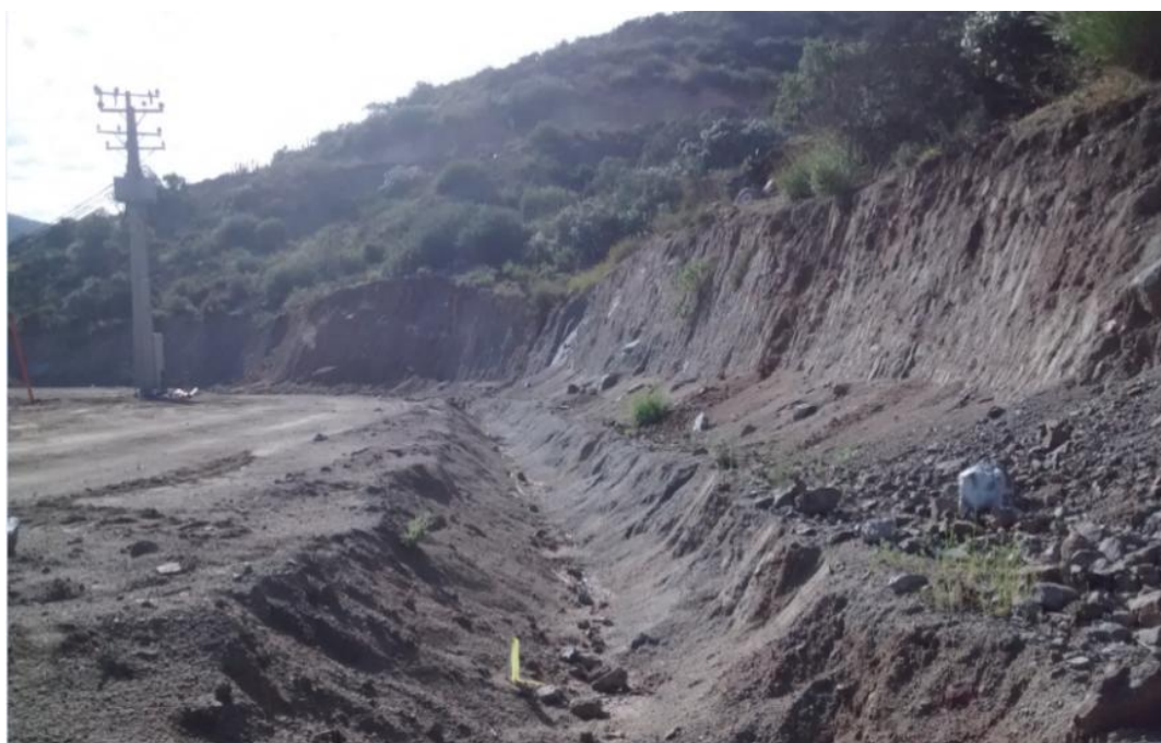
Figura 9: Estacas instaladas por topografía
