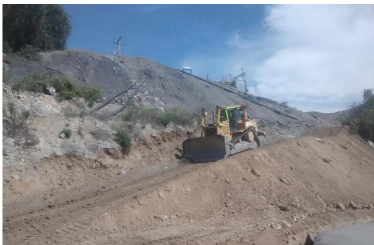
Figura 1: Inicio de trazado de tuberías
