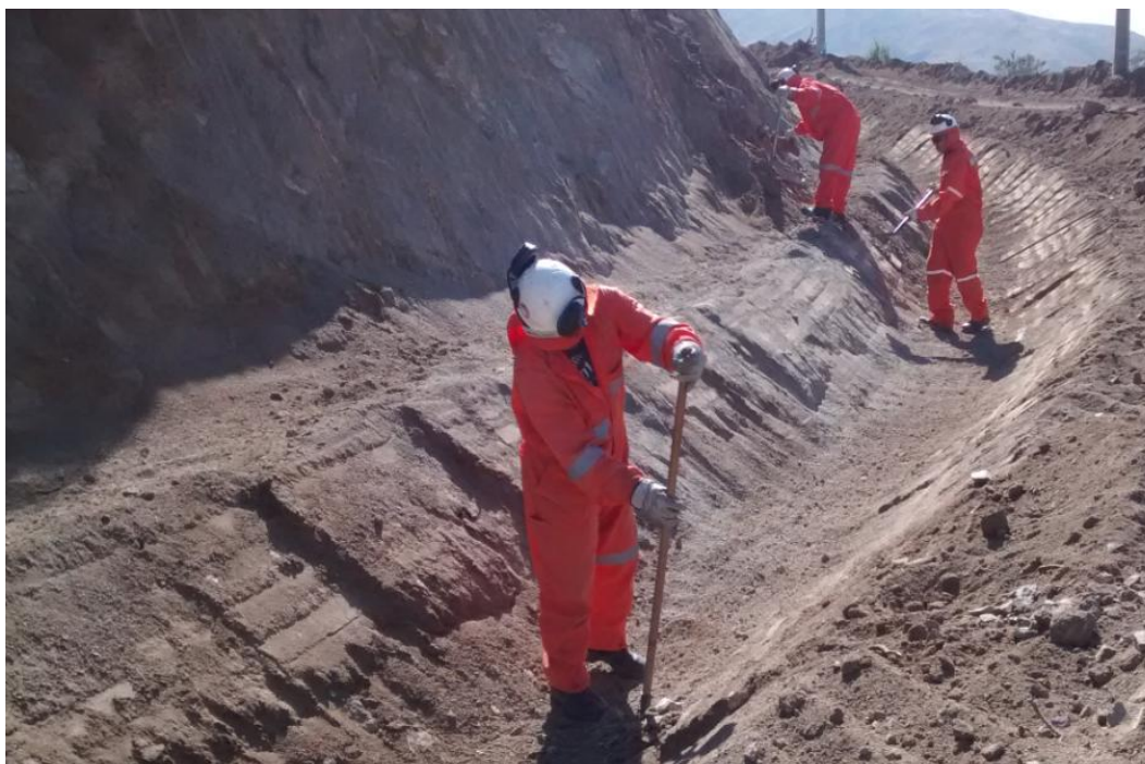
Figura 15: Limpieza y acomodo del canal, para instalación de geomembrana
