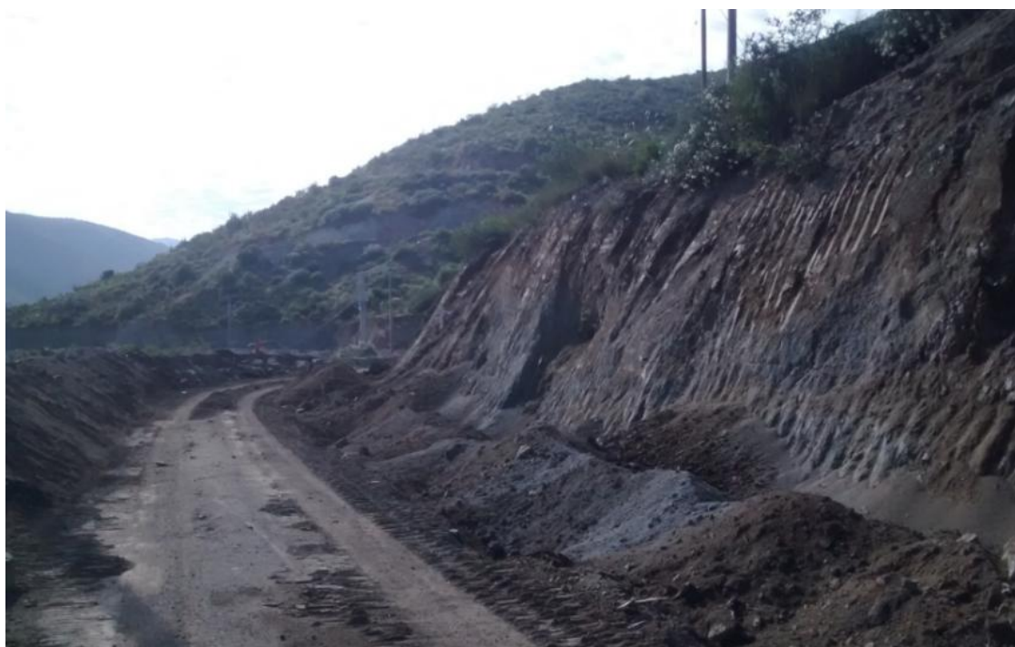
Figura 10: Rectificación del talud
