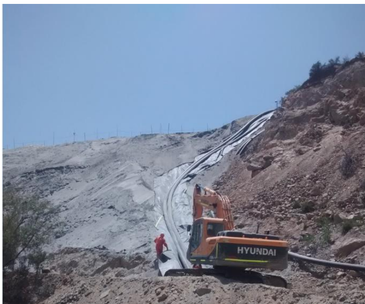
Figura 7: instalación de tubería HDPE en dirección hacia tranque III.
