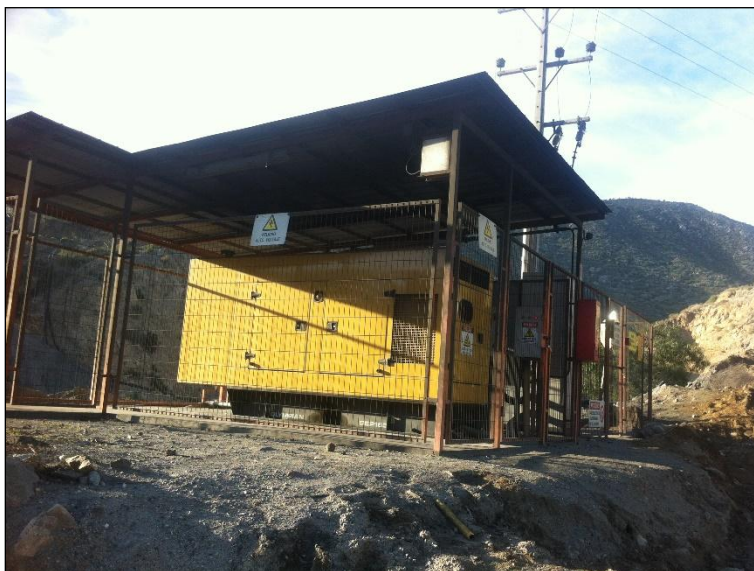
Figura 30: Fotografía a generador 150 KVA
