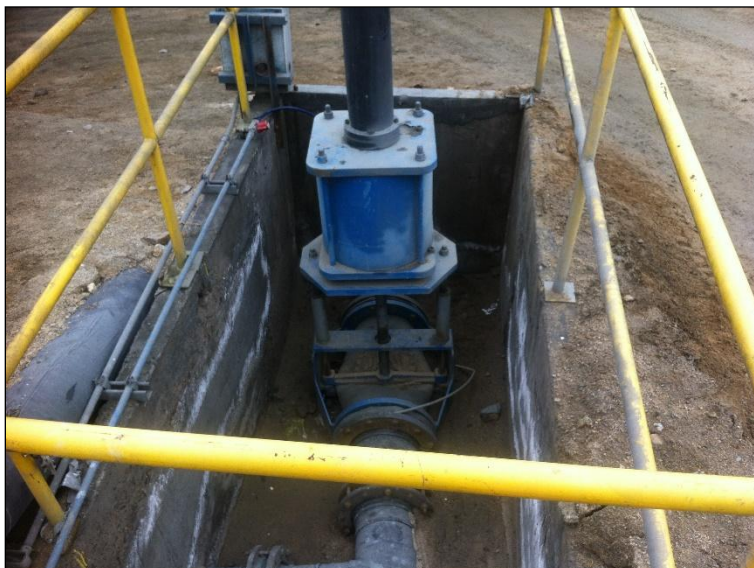
Figura 27: Fotografía válvula automática de paso a piscina de contingencia
