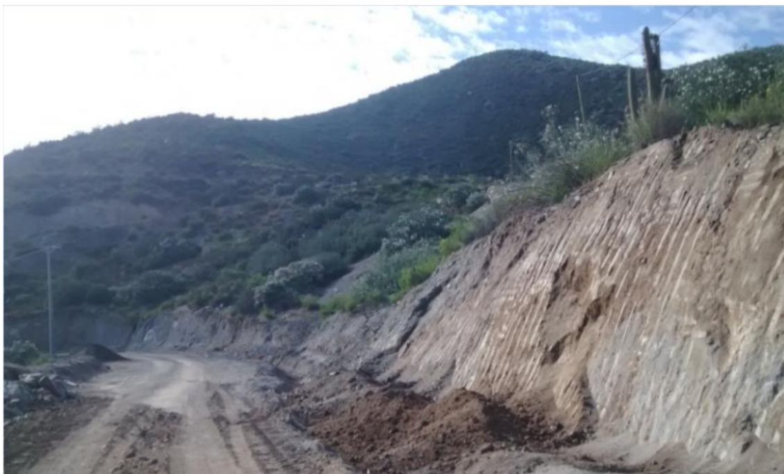
Figura 11: Rectificación del talud
