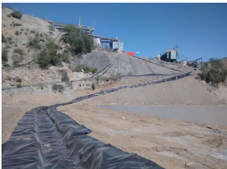
Figura 6: Zanja revestida en HDPE desde planta de beneficio.
