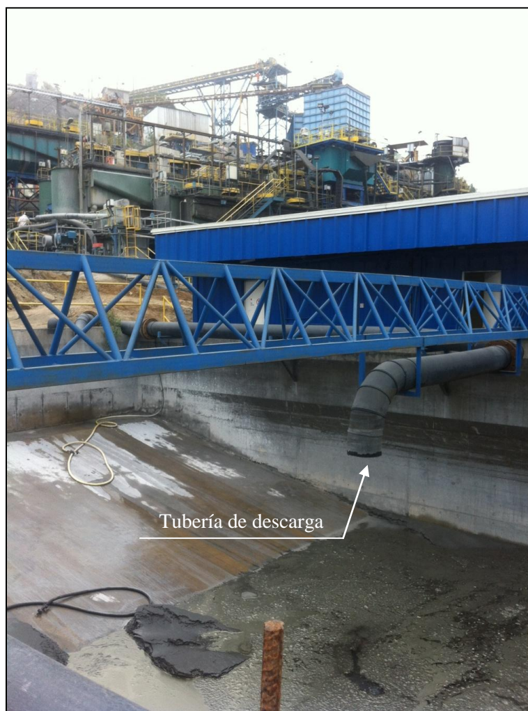
Figura 28: Fotografía a piscina de contingencia y tubería 12" de descarga
