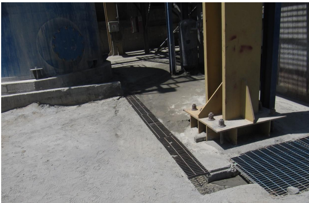
Figura 19: Canales interiores, área de flotación
