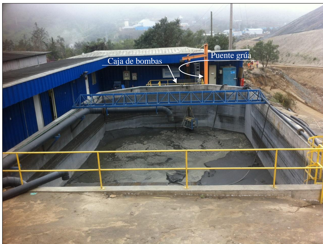
Figura 26: Fotografía, Piscina de contingencia 500m 3 y bomba a piso
